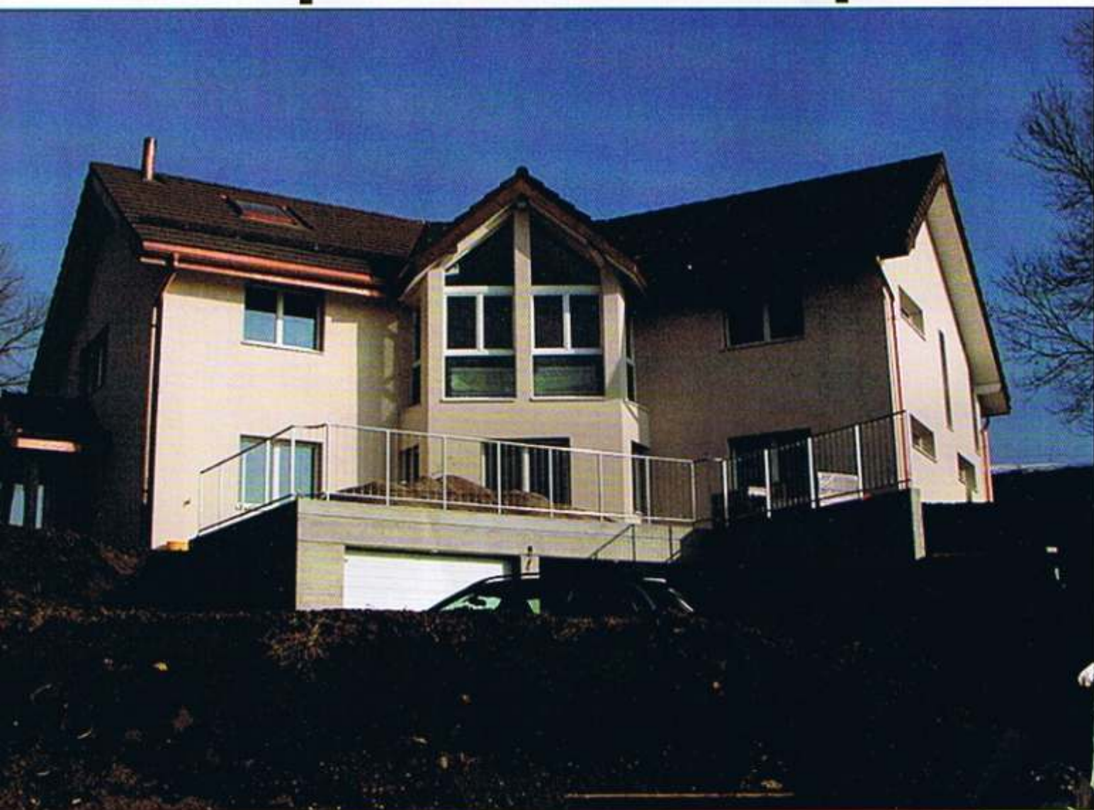
Vue générale de la villa.
